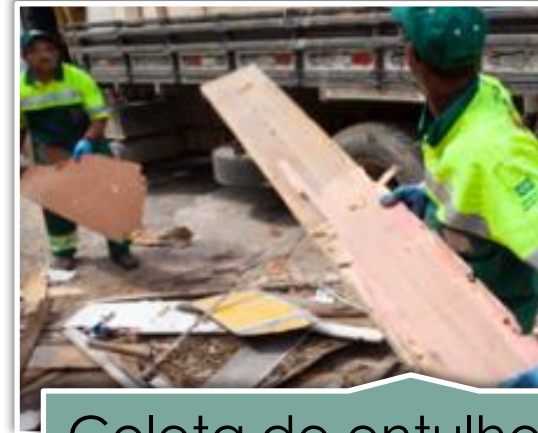
Coleta de entulho (RCC)
